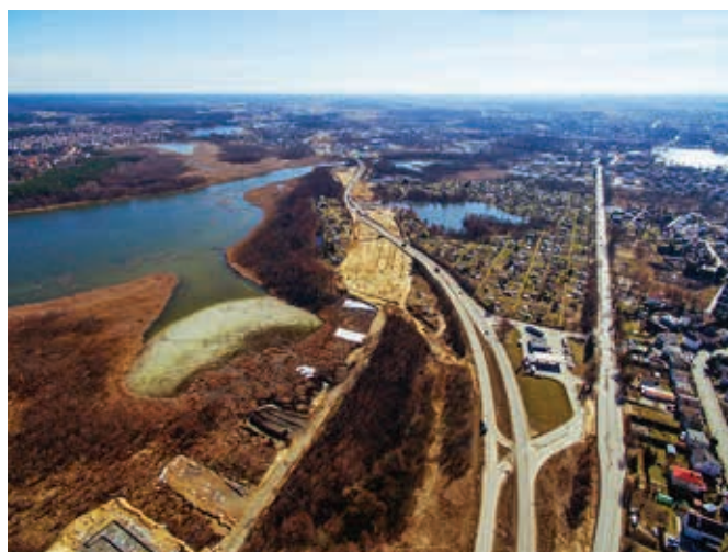
Ryc. 4. Obiekt MS-2 w trakcie wykonywania platform, marzec 2016 r.
