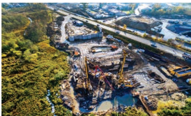
Ryc. 11. Obiekt MS-4 – podpora P3 w trakcie robót palowych, październik 2016 r.
