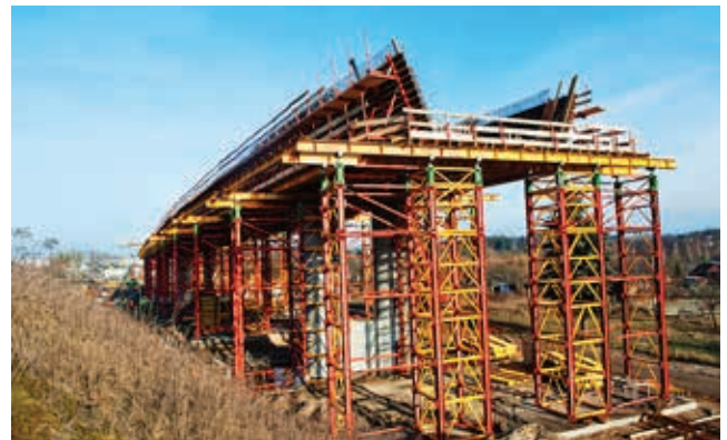
Ryc. 20. Obiekt MS-6 – rusztowanie pod ustrój nośny nitki prawej, marzec 2016 r.
