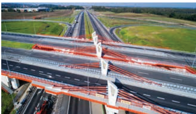
Ryc. 17. Obiekt WD-9 – widok z góry, sierpień 2017 r.
