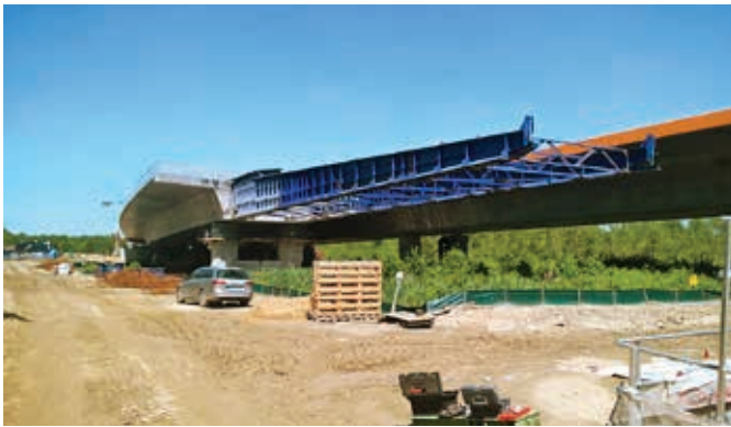
Ryc. 5. Obiekt MS-2 – nitka prawa w trakcie nasuwania, maj 2017 r.
