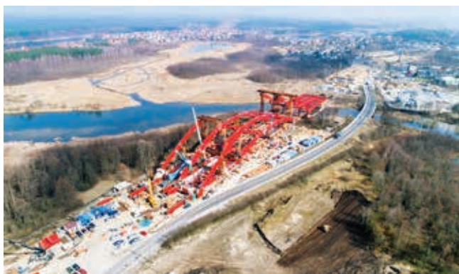
Ryc. 10. Obiekt MS-4 – widok z góry, marzec 2017 r.
